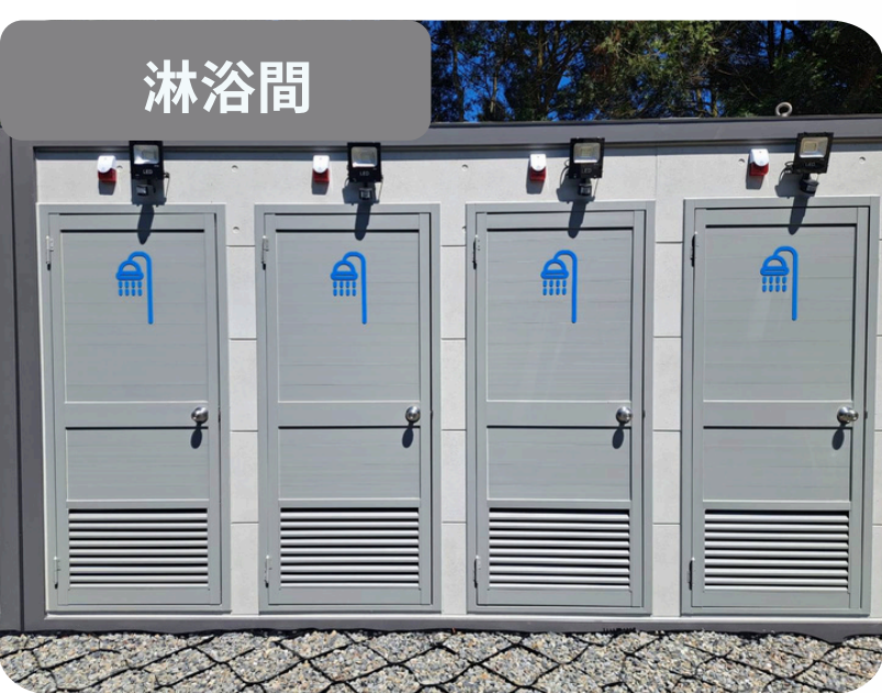
日月潭碼頭淋浴間新建工程
